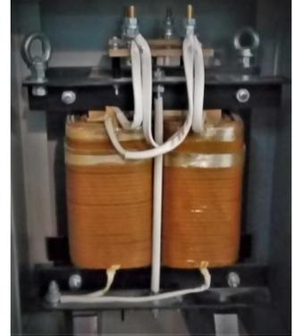
Согласно ГОСТ Р 50571.28 в цепях до и после разделительного трансформатора должны применяться автоматы с таким уровнем защиты от перегрузки, который допускает перегрузку трансформатора на 60% в течение часа, или автоматы без теплового расцепителя. Номинальная мощность медицинских трансформаторов должна находиться в пределах 0,5-10 кВА вне зависимости от количества фаз.
